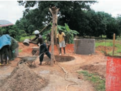
Los pozos se construyen mediante el sistema de moldes. Se excava el espacio suficiente, se dejan deslizar los moldes hacia abajo y en la parte superior se coloca el bocal realizado fuera.
